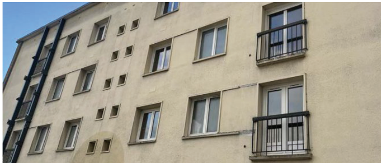
La façade des immeubles datant de 1963, avant transformation.
