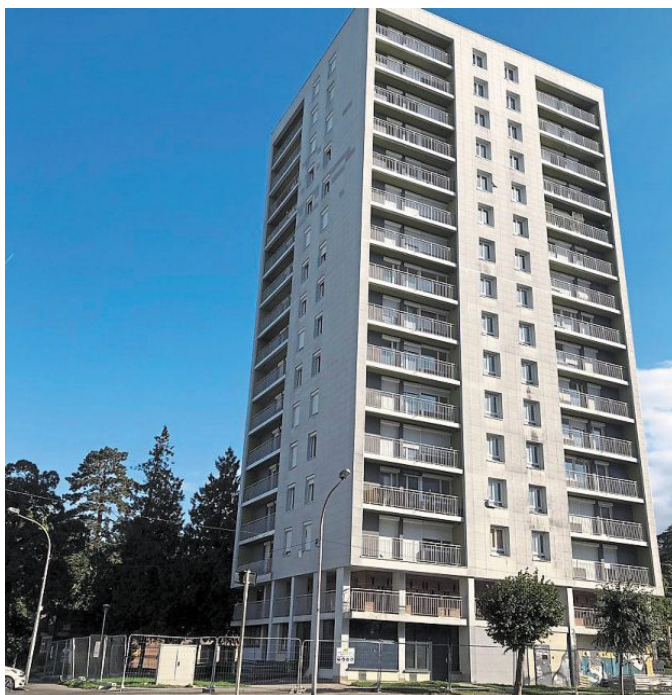
La démolition de la tour Taunton, située près de la Caf, devrait se faire avec un an de retard dans le quartier d'Hauteville.
