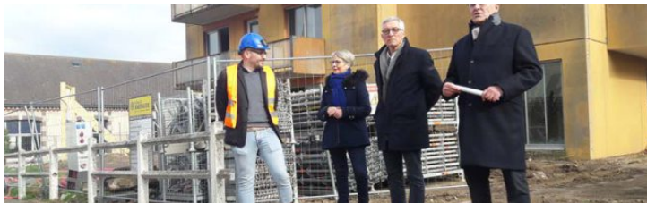
Compte tenu de sa proximité immédiate du centre d'animation sociale notamment, le bâtiment sera totalement emmitouflé
