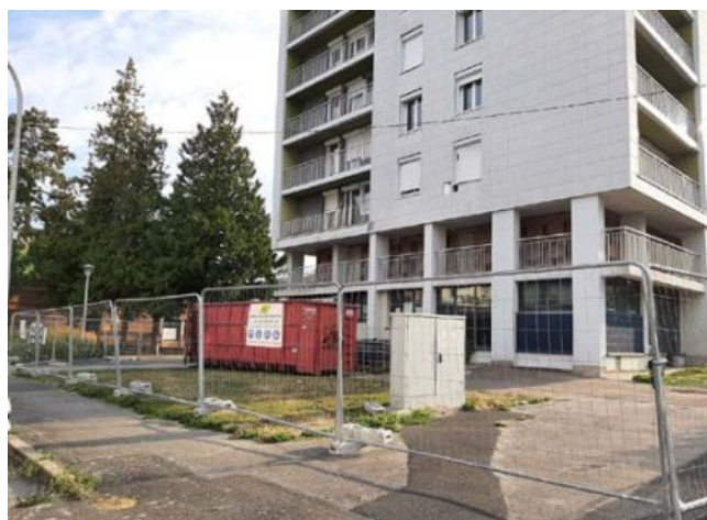
Des barrières entourent désormais le bâtiment.
